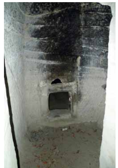
A gauche, une vue de la petite salle située entre l'anti-chambre et la cuisine. A droite, la chaufferie
